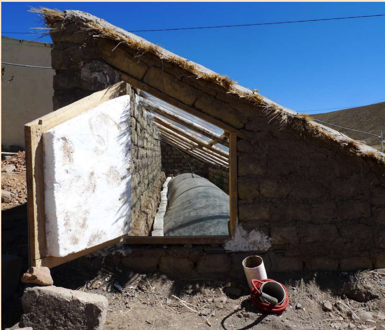
Figura 2: Biodigestor tubular adaptado a clima frío que considera aislante en zanja, color oscuro de plástico e invernadero compacto.
