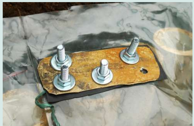
Figura 25: Secuencia fotográfica simulando la reparación “a la colombiana” de un hueco en un biodigestor tubular de plástico de invernadero, usando dos láminas de PVC, dos empaques, tornillos y tuercas.
