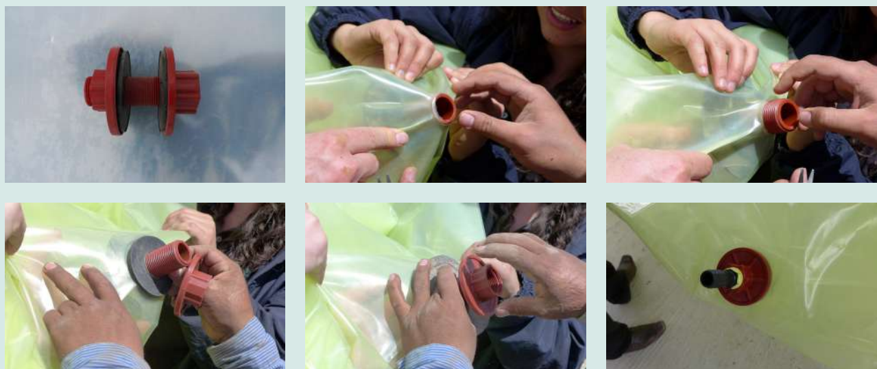
Figura 12: Secuencia fotográfica de la instalación de la salida de biogás en un biodigestor tubular de plástico de invernadero, usando un adaptador de tanque.
