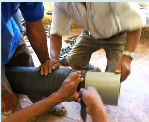
Figura 16: Imagen que ilustra la necesidad de continuar el amarre de liga de neumático 10 cm más, una vez cubierto el plástico, sobre la tubería.
