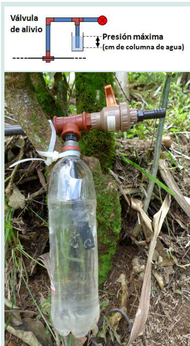
Figura 17: Arriba, esquema de la válvula de alivio. Abajo: fotografía de una válvula de alivio construida con una botella de refresco. En este caso la conducción de biogás acaba en la llave de la derecha, faltando su continuación hasta el lugar de consumo de biogás
