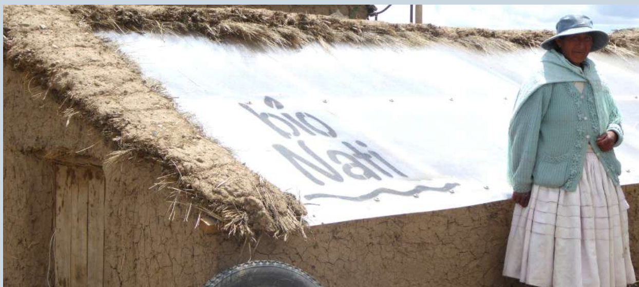
Imagen 3: Biodigestor tubular de plástico adaptado a clima frío (Bolivia) .
