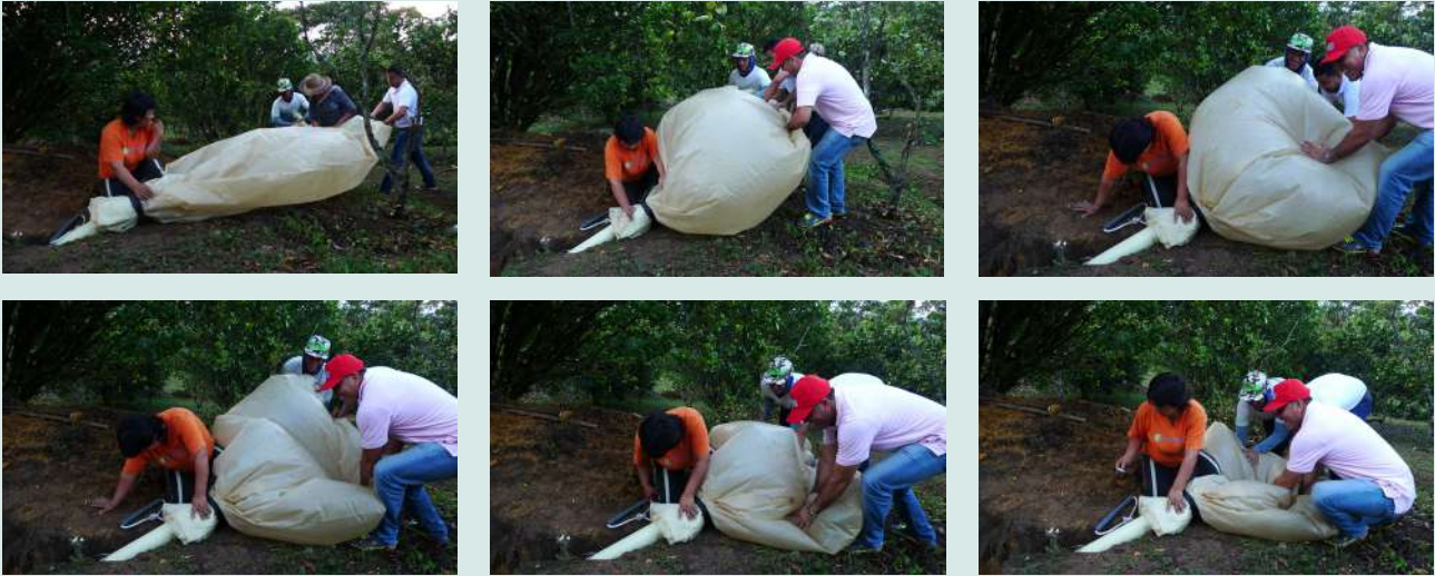
Figura 18: Secuencia fotográfica de cómo realizar el inflado de un biodigestor “a la colombiana” usando un pedazo de plástico tubular.
