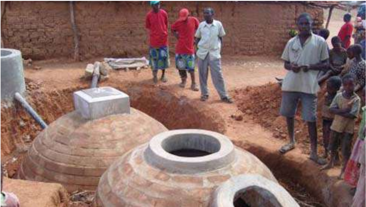
Imagen 1: Arriba- Diseño típico de un biodigestor de domo fijo con doble cámara, (Modelo CAMARTEC, Tanzania) . Abajo-biodigestor CAMARTEC construido, previo a ser tapado con tierra (CAMARTEC, Tanzania)
