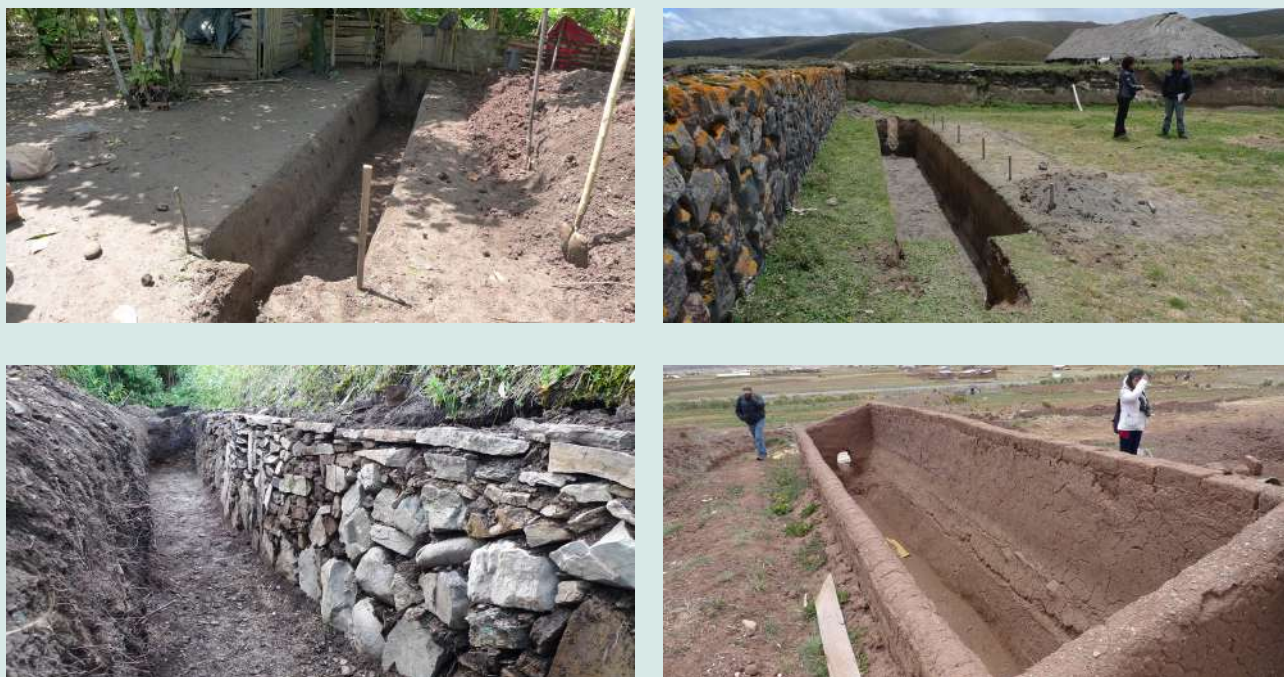
Figura 10: Ejemplos de zanjas para biodigestores tubulares.
