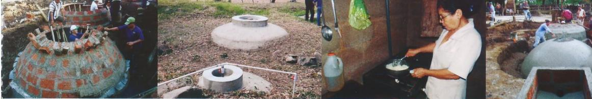
colas, etc.) y ante la ausencia de aire produce biogás, cuya combustión permite generar energía eléctrica y térmica; y fertilizante orgánico líquido y sólido de alta calidad para mejorar los suelos e incrementar el rendimiento de los cultivos y pastizales. Esto posibilita obtener múltiples beneficios económicos, ambientales y sociales.
