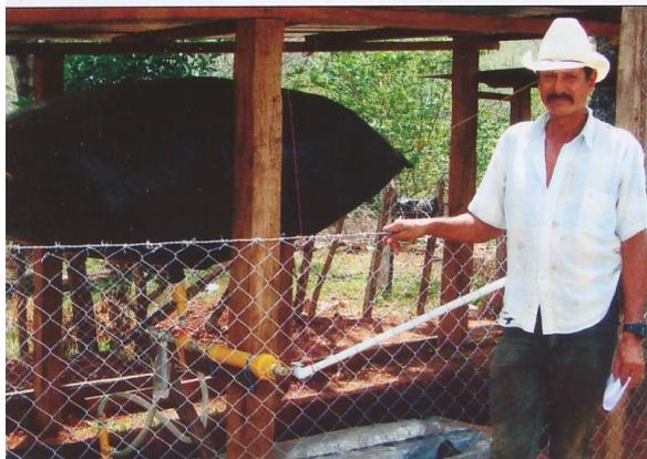
El modelo más popular, debido a su fácil instalación y manejo, es el biodigestor tipo bolsa, al que se le llama también “salchicha” o “bolis” por la forma que adquiere una vez que está completamente cargado con la materia a procesar.
