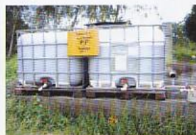
Tratamientos de aguas residuales de planta procesadora de camarón (Chinanadega, Nicaragua).
